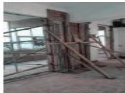
施工中(「模板及支撐」階段)
