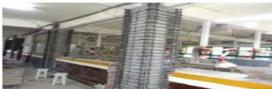
施工中(「鋼筋綁紮(封模前)」階段)
