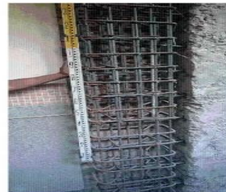
施工中(「鋼筋綁紮(封模前)」階段)
