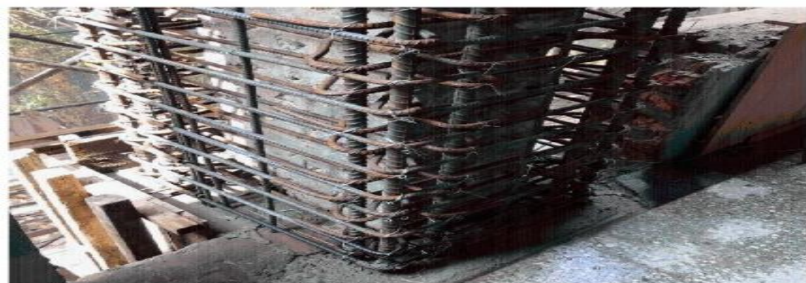
施工中(「鋼筋綁紮(封模前)」階段)
